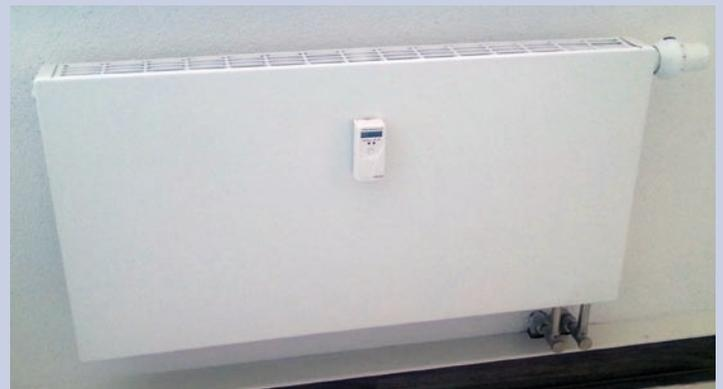
Heizkörper mit neuem Wärmemengenzähler
