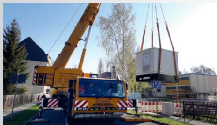
Durch den Krandienst Gerlach wurde die neue Trafostation an ihren Bestimmungsort in der Lindenstraße transportiert.
