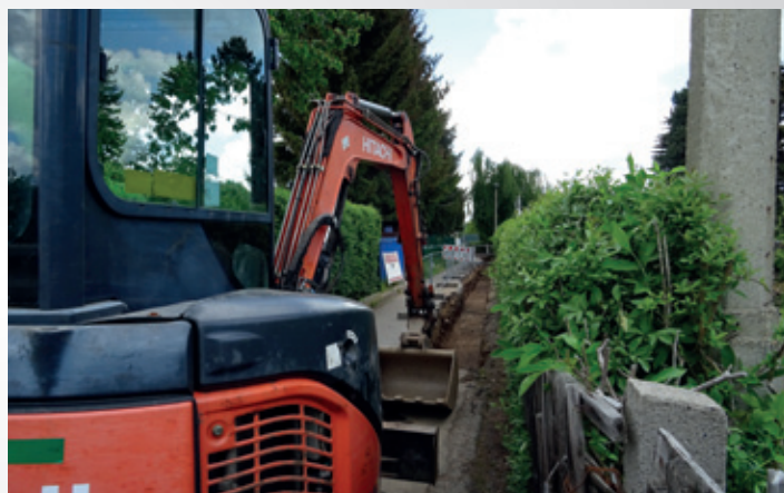
Aktuelle Baustelle Auf der Bleiche, Fotos: Stadtwerke
