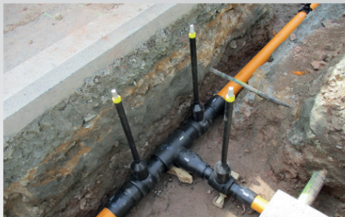
Einbau eines Schieberkreuzes an der Freiburger Straße 95 als vorbereitende Maßnahme für die o. g. Rekonstruktion der Gasmitteldruckleitung.
