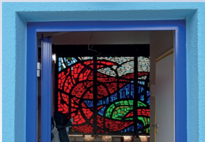
Ein erster Blick durch die Hintertür auf das eingebaute Buntglasfenster aus dem ehemaligen Glaswerk. Foto: Stadtwerke
