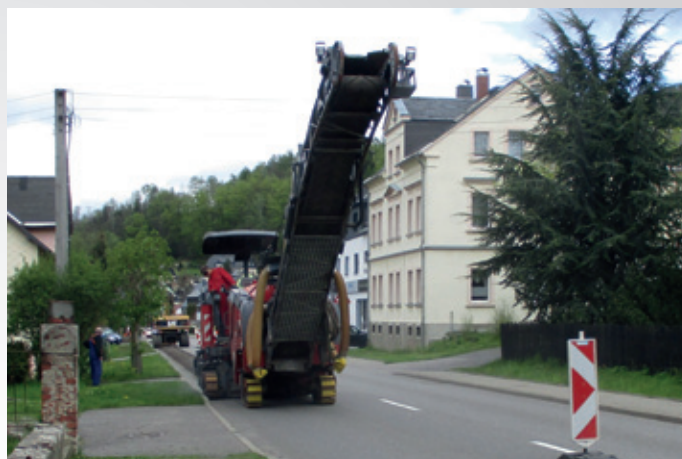
Asphaltfräse im ersten Bauabschnitt an der Zollstraße.
