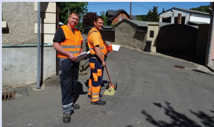
Bild: Die letzte große Begehung des gesamten Gasnetzes fand 2018 statt. Damals prüften Axel Baumann (Stadtwerke Annaberg) und Mario Breternitz (Hermann Sewerin GmbH) die Olbernhauer Gasleitungen auf Leckagen. (v. l.)
