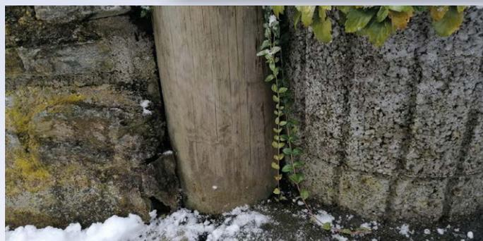
Der Strommast ist hier so eng eingebaut worden, dass bei einem Mastwechsel die Mauer rückgebaut werden muss.
