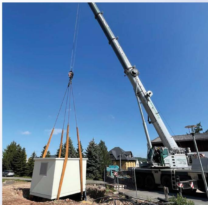
Per Kran wird die fertige Trafostation in die vorbereitete Fundamentgrube gehoben.
