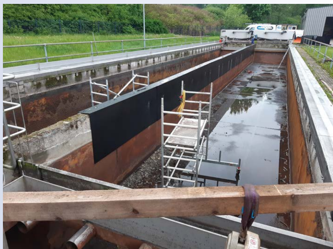
Sanierungsarbeiten an der Mittelwand des Vorklärbeckens der Kläranlage Olbernhau. Foto: Abwasserzweckverband Olbernhau
