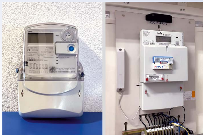
links: moderne Messeinrichtung (mME), rechts: intelligentes Messsystem (iMS) inklusive Smart Meter Gateway (kleiner Kasten blau-weiß in der Mitte) Fotos: Stadtwerke Olbernhau GmbH
