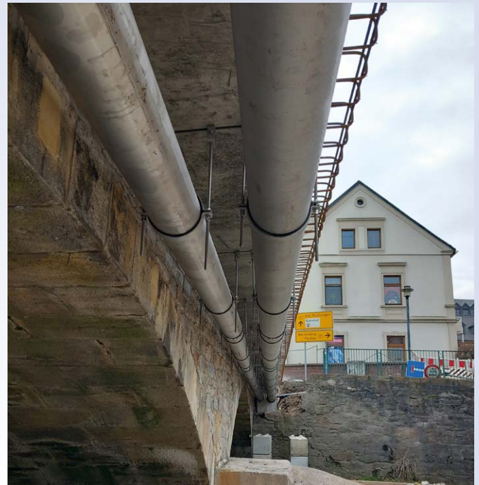
Neu verlegte Gas- und Trinkwasserleitung unter der Marktbrücke. (Foto: Stadtwerke Olbernhau)
