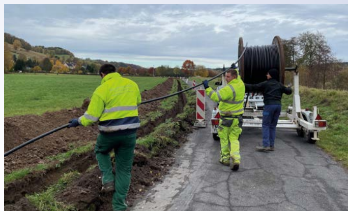
Einziehen des neuen Mittelspannungskabels im vorbereiteten Kabelkanal. Zum System eines Mittelspannungskabels gehören jeweils drei Stränge, die einzeln verlegt werden. Foto: Stadtwerke Olbernhau
