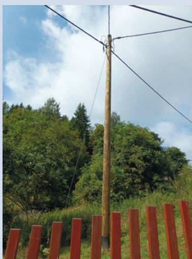
Einer der neuen Freileitungsholzmasten am Verlängerten Dörfelweg
